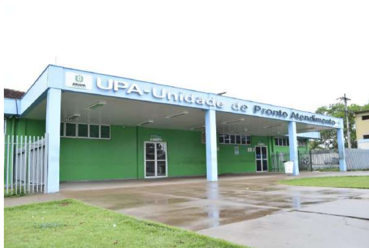
Figura 1: Unidade pronto atendimento (Upa) novo horizonte.
