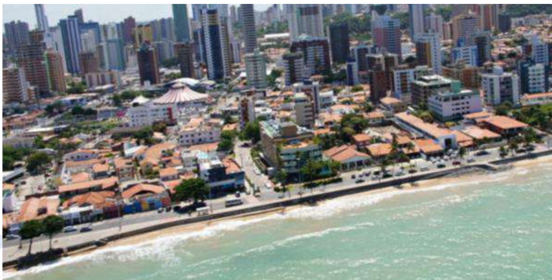
Figura 6 - Ondas avançando até o muro de contenção que separa a praia de Manaíra da Av. João Mauricio. Fonte: SPU (2013).
