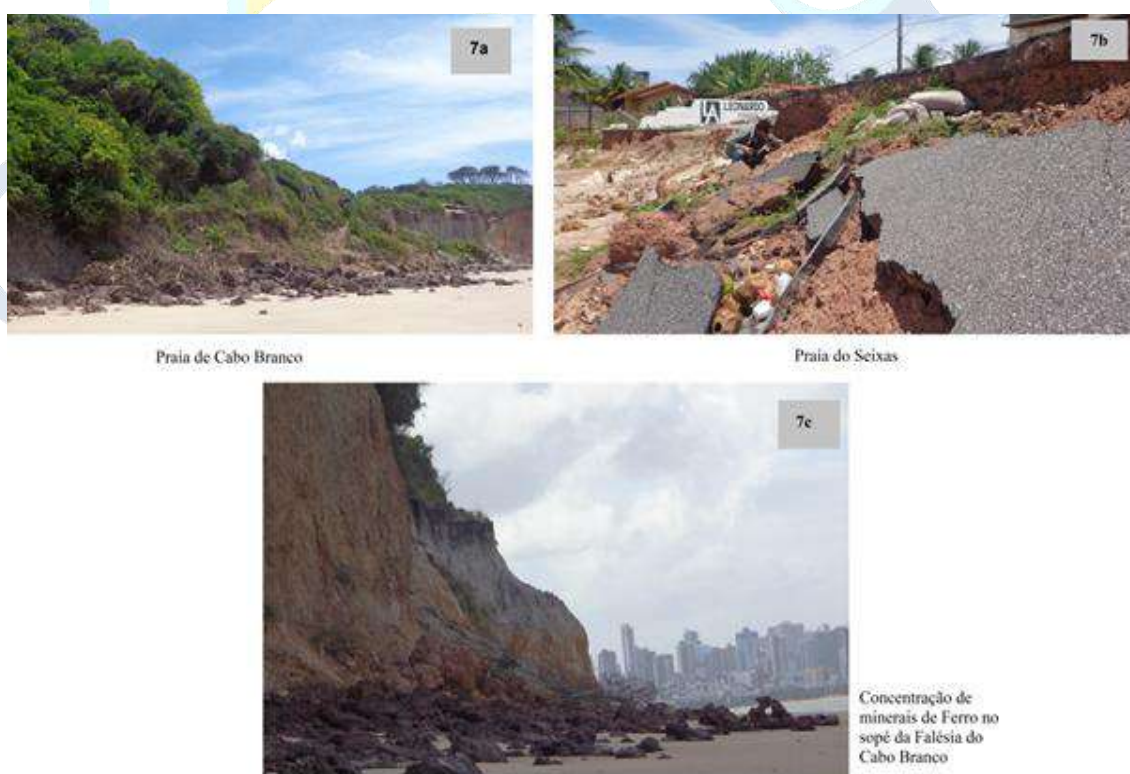
Figura 7 – (a) Destruição da vegetação natural em Praia de Cabo Branco; (b) Destruição de estruturas artificiais e exposição de camadas de aterros artificiais na praia do Seixas; (c) Concentração de minerais pesados (ferricretes) no sopé da Falésia do Cabo Branco.
