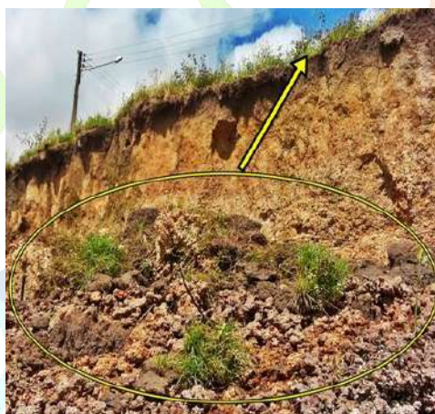
Figura 18. Erosão da parte superior da margem. A seta indica o local de deslizamento do arbusto.
